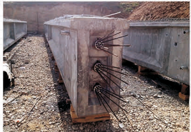
اجرای عملیات پیش تنیدگی در تیرها
