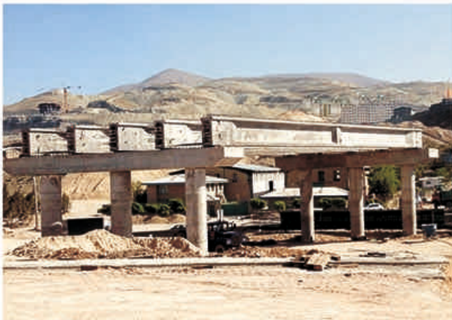
اجرای عرشه پل
