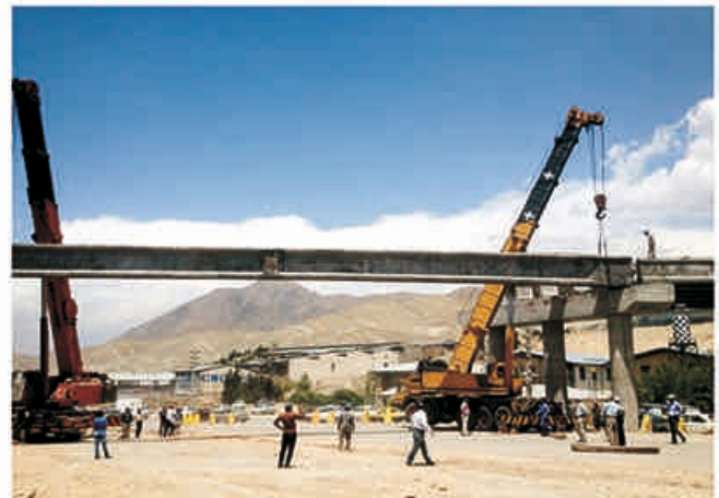
نصب تیرهای پیش تنیده
