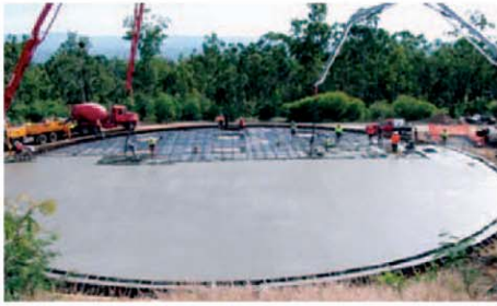
Slab pour in progress
